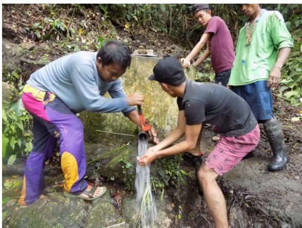
Werkzaamheden aan watersysteem
