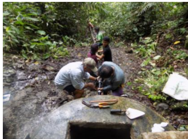
Werken aan waterreservoir
